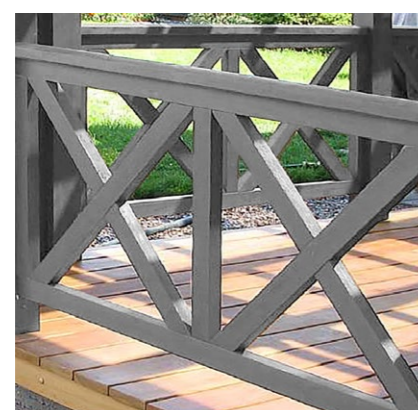
Деревянное ограждение мостиков, террас, лестниц и видовых площадок (сосна, лиственница)
